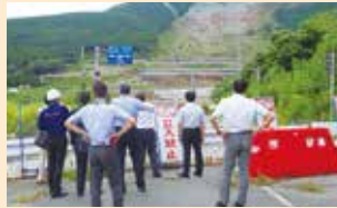
阿蘇大橋大崩落現場
