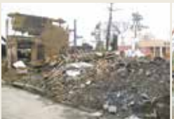
糸魚川大火現場視察
